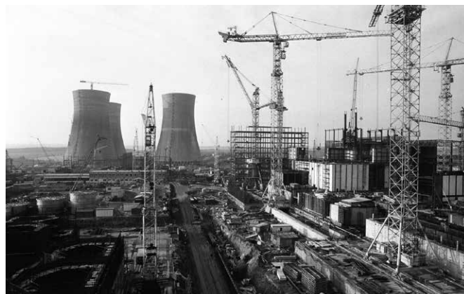
Pohled na rozestavěnou halu (HVB 1) a západní chladicí věže v listopadu 1981
