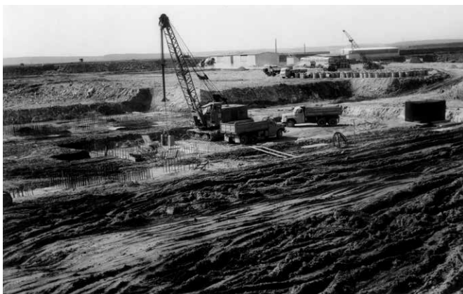
Zemní práce v prostoru hlavního výrobního bloku - 1978
