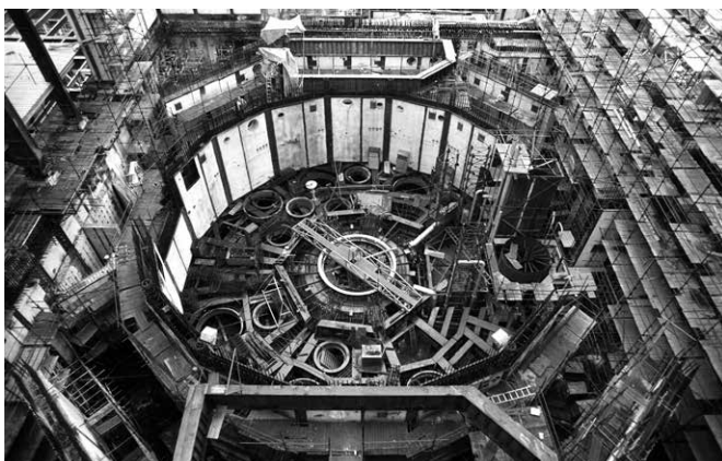
Rozestavěná šachta 1. reaktoru v březnu 1982
